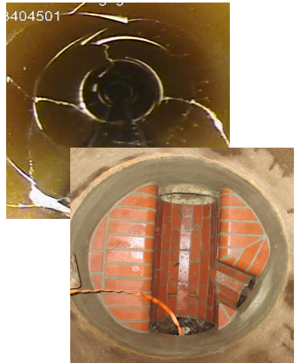
Bilder hinten: vor der Sanierung vorne: nach der Sanierung
