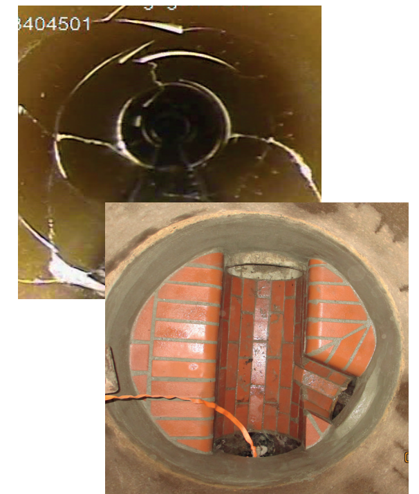
Bilder hinten: vor der Sanierung vorne: nach der Sanierung
